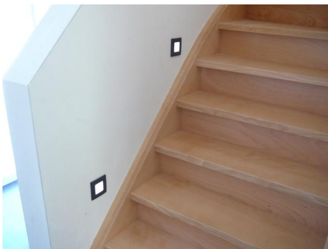
Esempio di luci di orientamento indirette che impediscono l'accecamento. (Foto: Deltalight)
